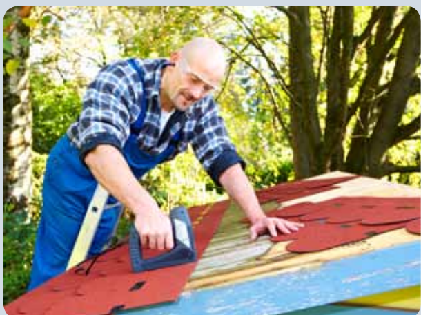
Schnelles Befestigen von Bitumenschindeln.
