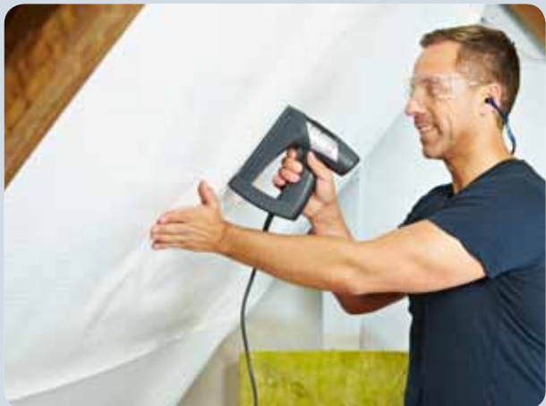
Folie beim Dachbodenausbau einfach befestigen.
